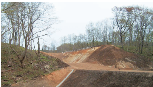
道路建設のために分断化された林
