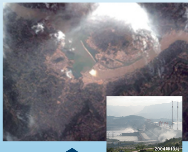
締め切り1ヶ月後の三峡ダム（2003年7月17日）
