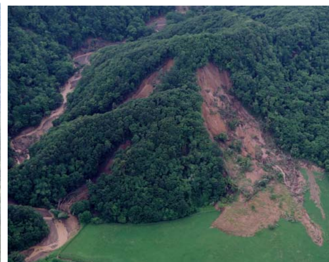
2003年厚別川上流域の崩壊状況
