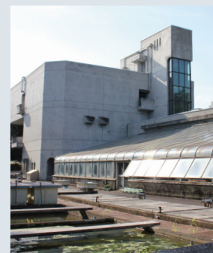
水環境実験施設
