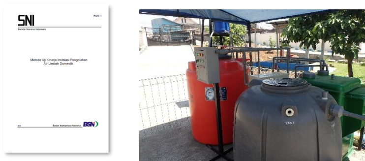
図 2.4.8 試験方法（草案）と性能評価試験のトライアル現場に設置された現地の排水処理槽
