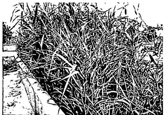
写真24 アシ植栽水路の状態
