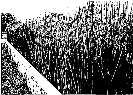
写真 26 フトイ植栽水路の状態
