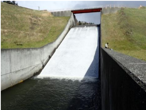
写真3 北辰ダムの放水口
