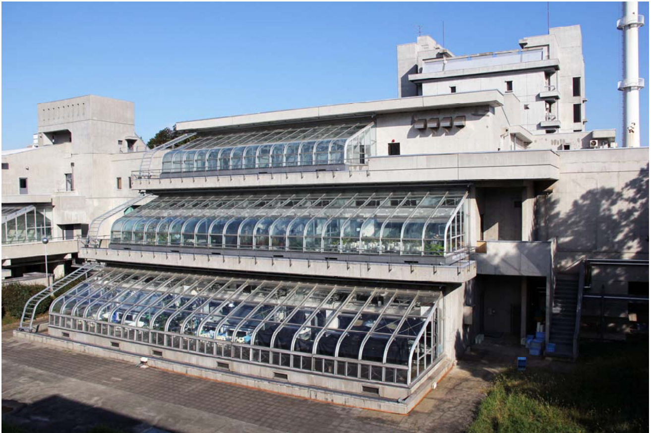
図 1 施設外観。建物南側の 1、2 階が温湿度等の環境制御可能な材料提供温室、3 階は温室の中に自然光型チャンバーが設置されている。
