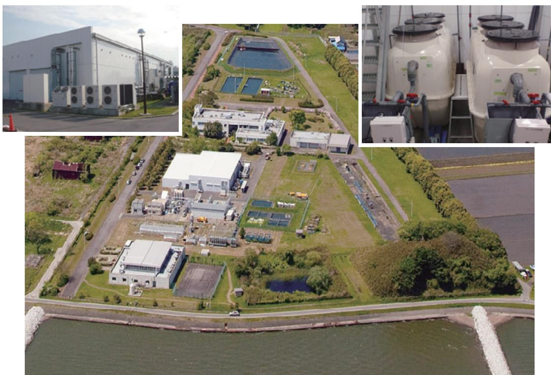
水環境保全再生研究ステーション全体 (中央) と、バイオ・エコエンジニアリング研究施設 (左上) および生活排水高度処理実験用浄化槽 (右上) [詳しくは 3 ページからの記事参照]
