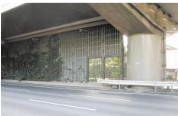
図3 植物による大気浄化の効果を指して、高架道路下部に設置された隔壁(グリーンウォール)
