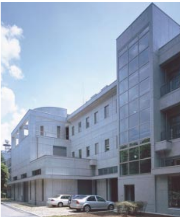
写真1 循環・廃棄物研究棟(正面)
