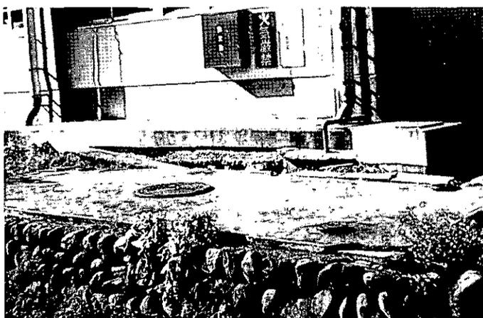
写真 4.3 六日町役場の基礎の抜け上がりによる被害状況
