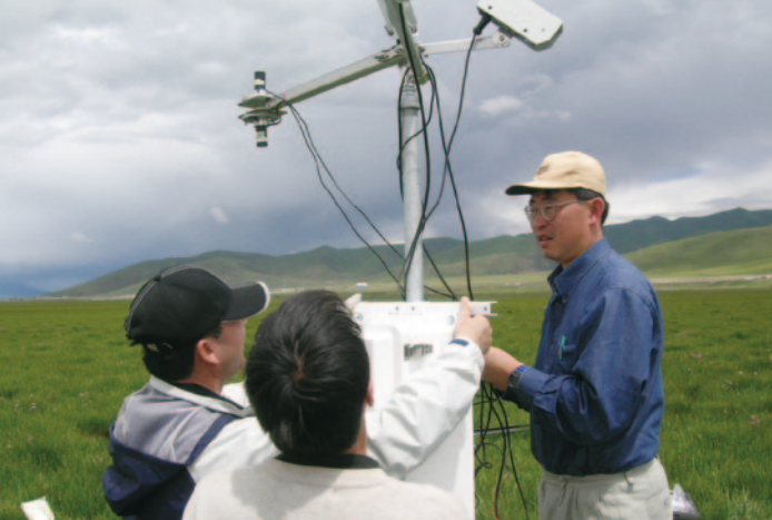
チベット当雄湿地サイトで観測機器の設置作業
