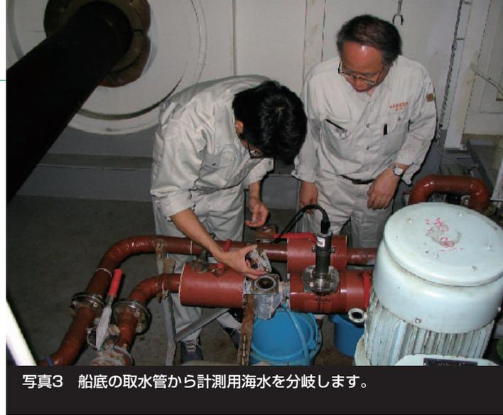
写真3 船底の取水管から計測用海水を分岐します。
