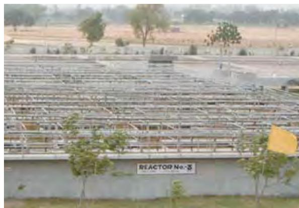
●生活排水への嫌気性処理技術（UASB法）の適用例（インド）。処理水質が不十分なため、水質維持のための適切な運転方法や後段処理技術の導入が求められている。
