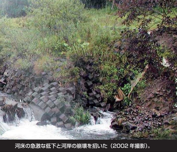
河床の急激な低下と河岸の崩壊を招いた（2002年撮影）。
