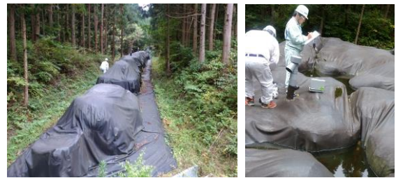
図1 仮置場の調査（右は内部のガスを調べています）
