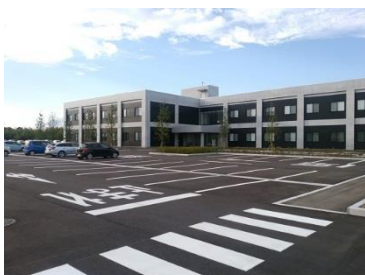
福島県環境創造センターの外観 (駐車場が完備されました)
