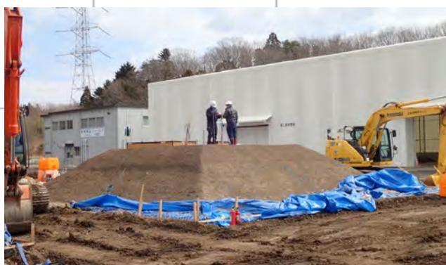
図 1 技術実証フィールドで構築中の実験盛土
