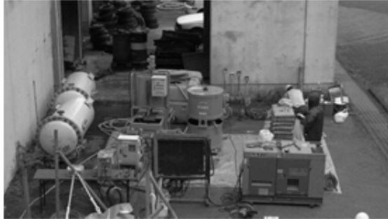
(a) 使用機器設備
