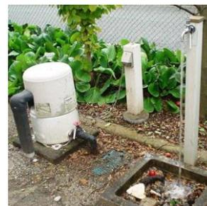
写真1 左)手押しポンプ式井戸、右)電動ポンプ式井戸
