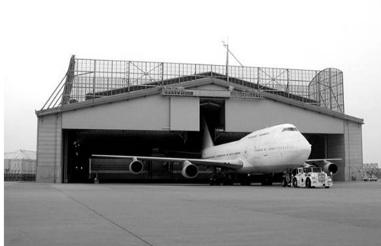
写真 4.1 エンジン試運転施設（成田国際空港）
