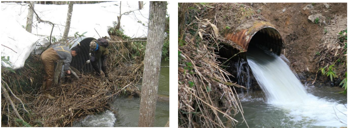
図 3 イトウの産卵期、カルバート上流側はしばしば大量の倒流木や小枝でふさがる（左）。反対に下流側には大きな落差が生じて、イトウの産卵遡上に支障を来す（右）。
