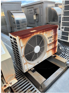
空冷コンデンシングユニット 撤去、交換
