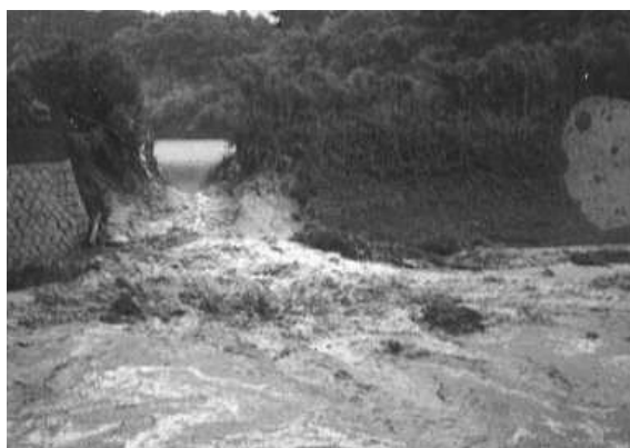
図3．豪雨によるため池の決壊事例.
