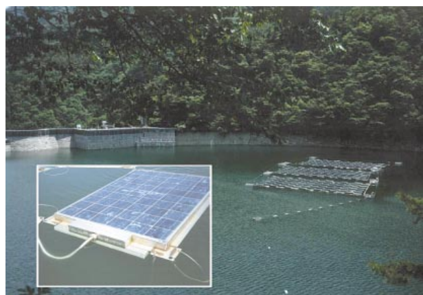
図6．水上設置型太陽光発電施設（30kw）
