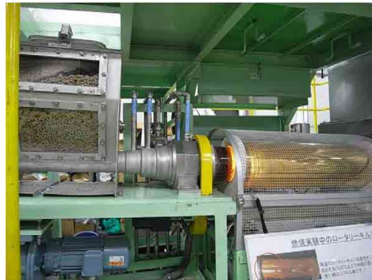
投入口と一次燃焼炉
