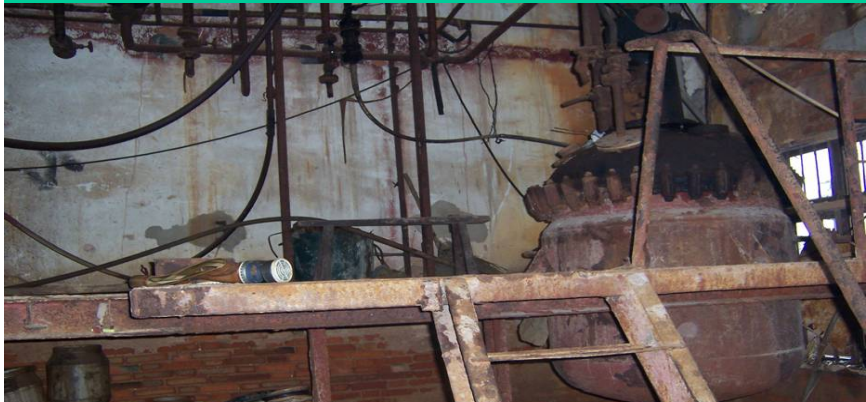
Production site (Chlordane & Marex)
