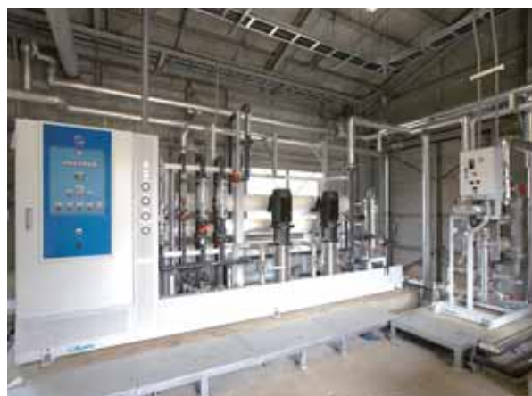
実験廃水処理水再利用RO(逆浸透)設備
