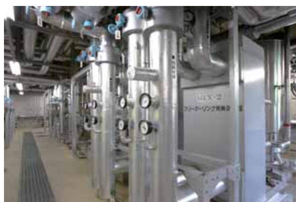
フリークーリング用熱交換器（地球温暖化研究棟）
