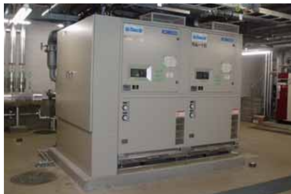
省エネ型スクリーウ冷凍機（地球温暖化研究棟）
