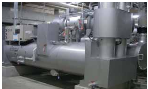
写真：省エネ型ターボ冷凍機
