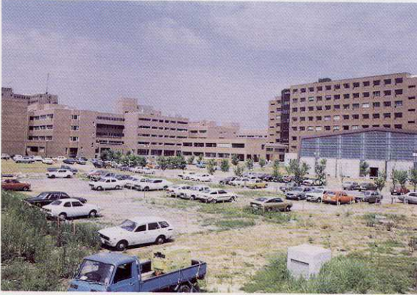
写真6 1 筑波大学中央管理棟西歩道橋
