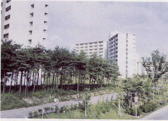
写真15 竹園1丁目802 東竹園北橋歩道橋
